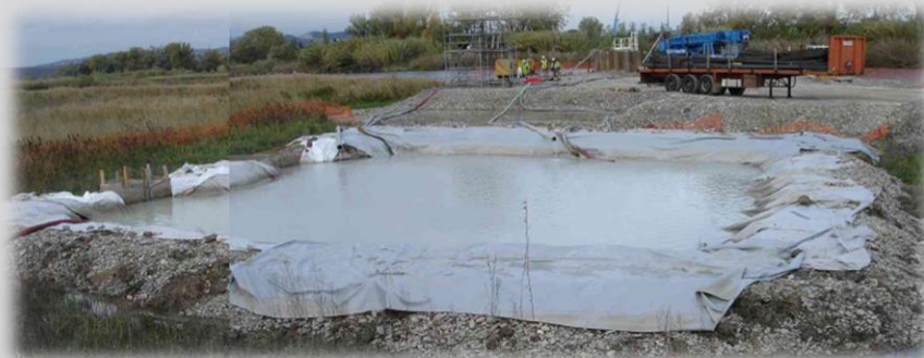
Figure 11 : Bassin provisoire de décantation des MES et autres polluants (Source photo : ADEV Environnement)
