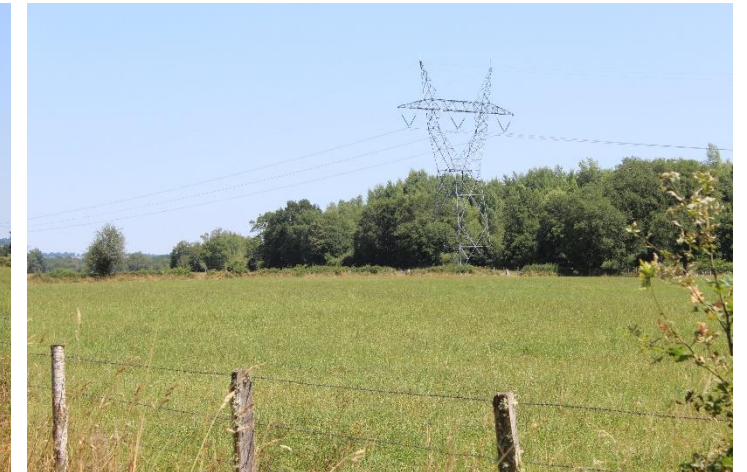
Photo 19 : Ligne à haute tension qui traverse la zone de projet avec en arrière-plan la butte boisée des Grands Champs - Source : Photo J.Vignes
