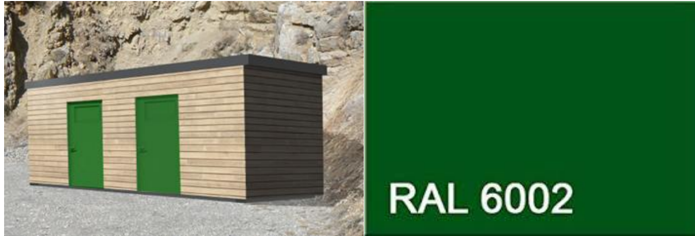
Figure 8 : Le poste de livraison est en béton recouvert d'un revêtement en bois, comportant des portes métalliques vertes (RAL 6002).
